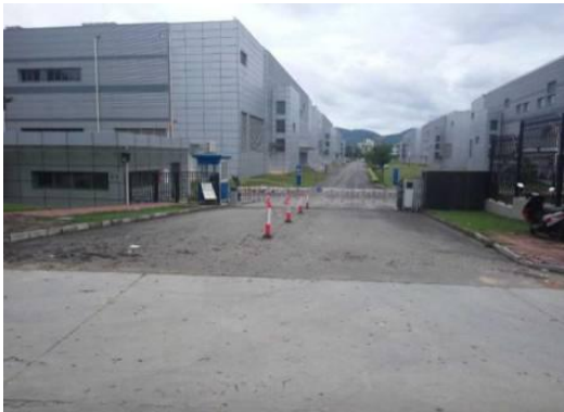
项目西侧腾讯数据中心
