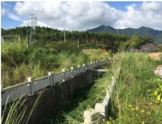
道路西侧现状渠道
