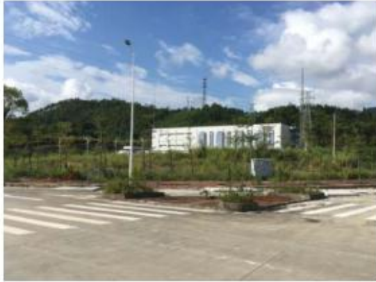
道路西侧变电站
